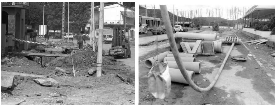
Figures 64 i 65. Imatges del passeig Mossèn Constans durant les seves obres
