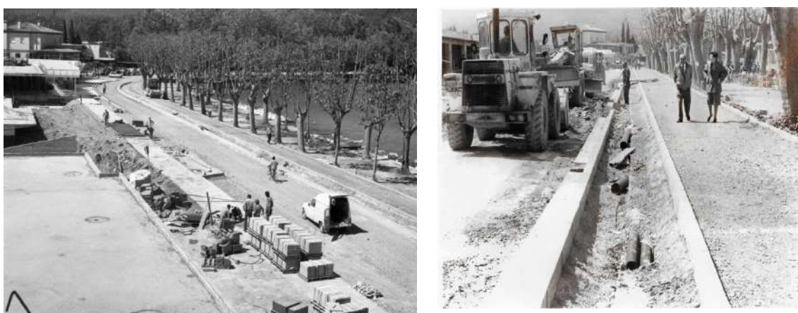
Figura 50 i 51. Imatges del passeig de l'Estany durant les seves obres
