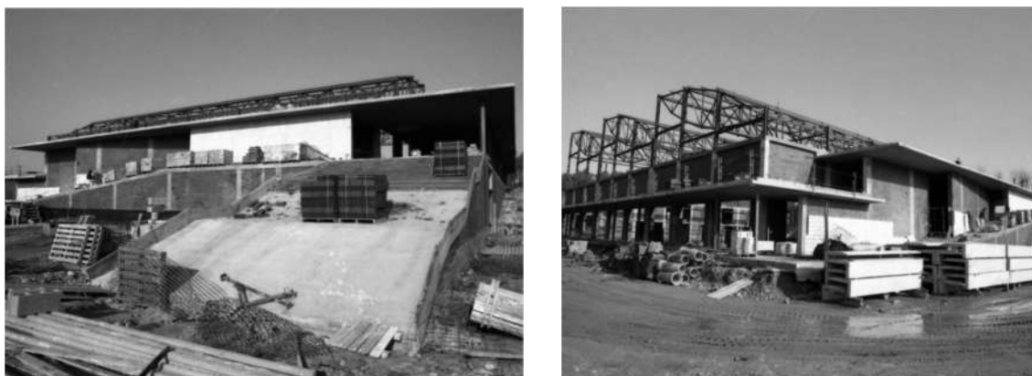
Figures 28 i 29. Imatges del pavelló poliesportiu durant la seva construcció
