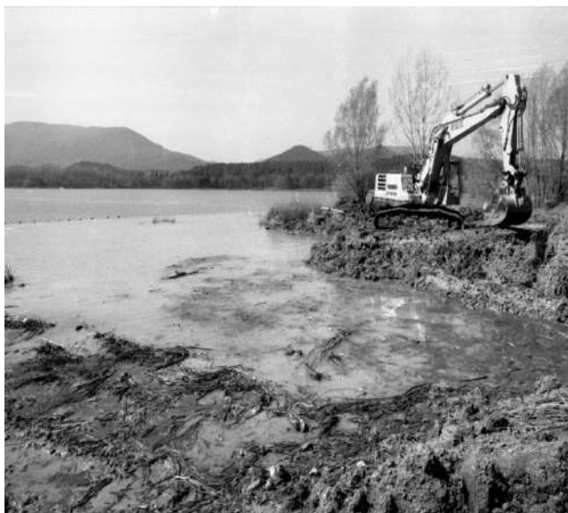
Figura 9. Imatge d'una màquina treballant amb les obres de la pista de rem
