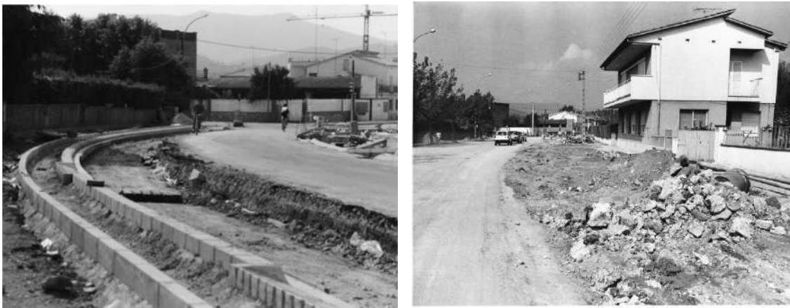
Figures 62 i 63. Imatges del passeig Mossèn Constans durant les seves obres
