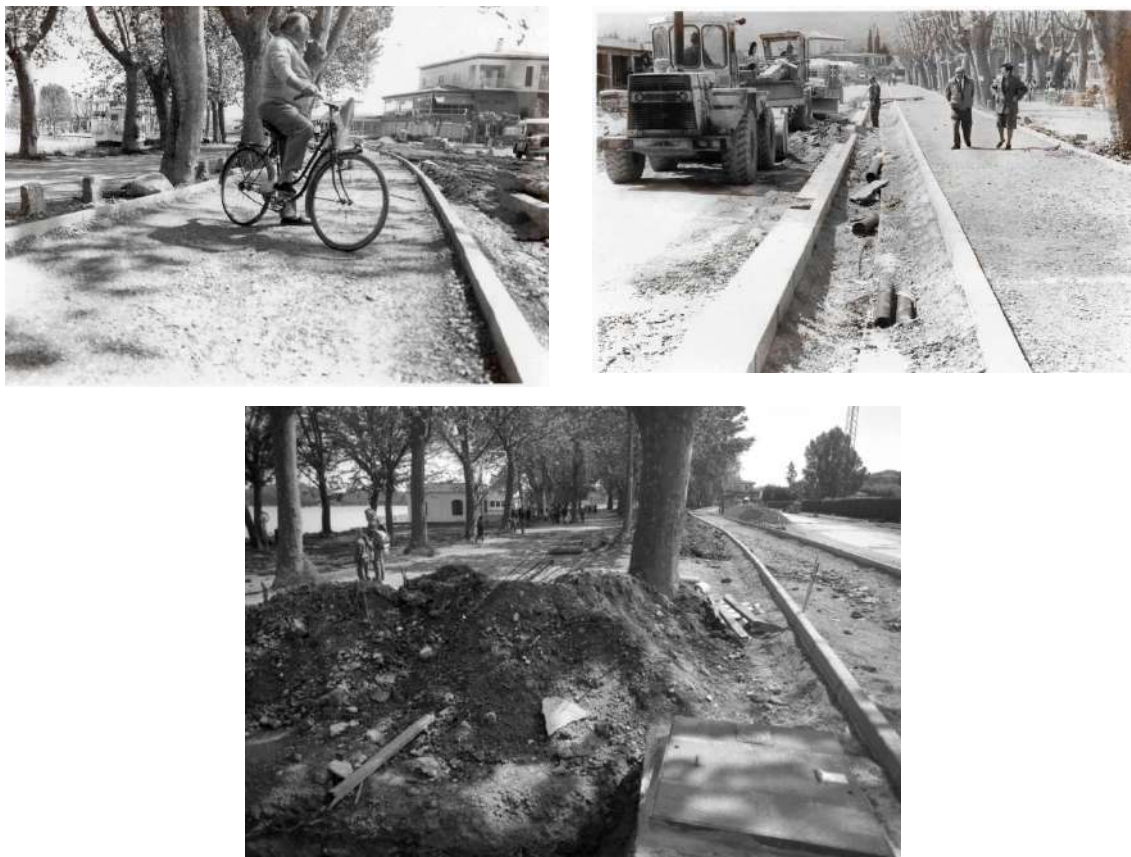
Figures 52, 53 i 54. Imatges del carril bici i el passeig de l'Estany en construcció
